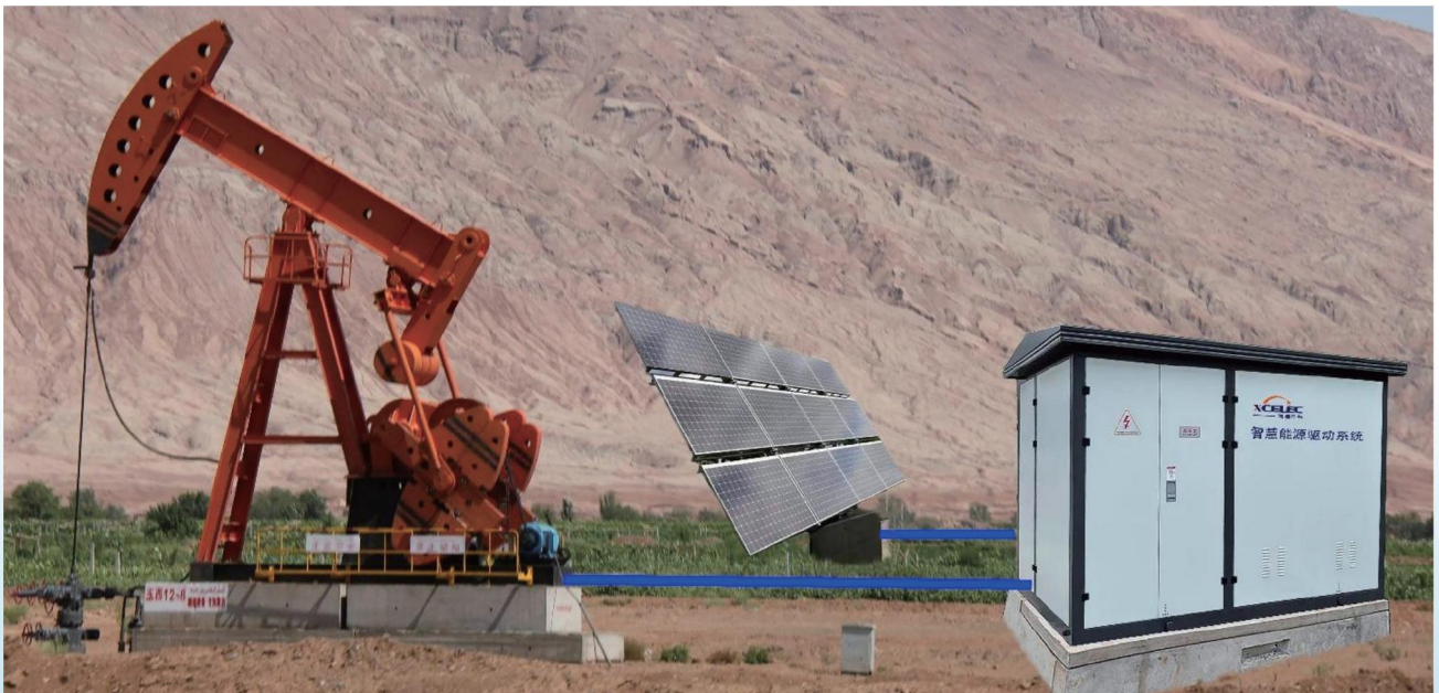
● 图 5 太阳能供电抽油机应用场景图
